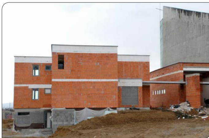
> Pochmúrne počasie, ktoré vládlo niekoľko dní, možno využiť na interiérové murárske práce. V priestoroch rozostavaného pastoračného centra na sídlisku Juh stihli v poslednom období napríklad nainštalovať kúrenie. „Na Jozefa sa betónovali podlahy, chystáme sa obkladať toalety. Fasádu by sme radi kompletne dokončili do 14. júna. Práve v tento deň bude v našej farnosti biskup Viliam Judák udeľovať sviatosť birmovania, tak prečo túto vzácnu návštevu nespojiť so slávnostným prestrihnutím pásky a posvätením nových priestorov,“ informoval južanský farár Jozef Varhaník. Ak všetko dobre dopadne, pastoračné centrum bude slúžiť mládeži už počas tohtoročných letných prázdnin. (jč)
