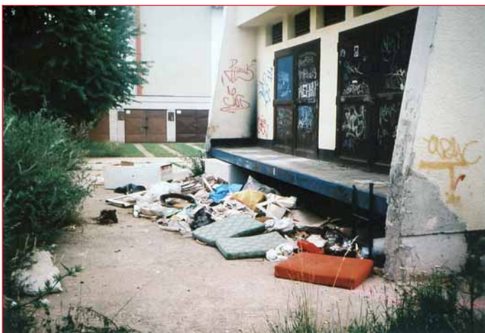
Takto to vyzerá pri trafostanici na Bezručovej ul. Pomaly ale isto sa stáva elderadom neprispôsobivých občanov... Obyvatelia z neďalekej Inoveckej ul. ako riešenie navrhujú trafostanicu oplotiť. Snímka (zb)
