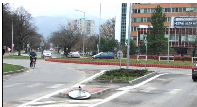
Rozkopávky na Soblahovskej ul. sú povolené maximálne do 30. októbra t. r. Snímka (jč)
