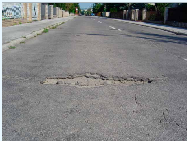
Ulica Jána Zemana na sídlisku Noviny je vo veľmi zlom stave. Najhoršie sú výtlky, hlboké aj 15 cm či trčiace kanálové vpuste. Čo urobia kompetentní? Snímka Anton Pleva
